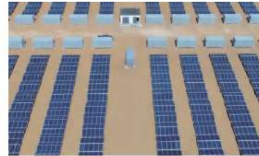
Centrale électrique au sol
