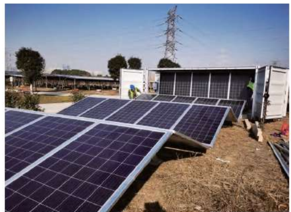
④ Déplier le panneau solaire photovoltaïque
