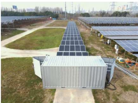
⑤ Installation de câbles
