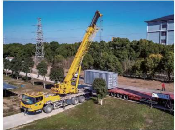
② Levage en position
